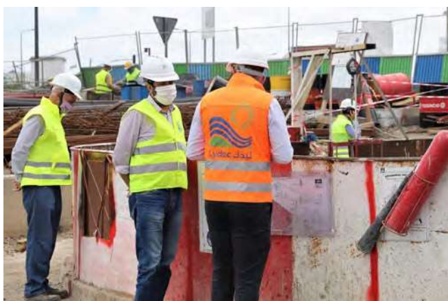
Des techniciens de la Lydec, opérateur privé d'eau et d'électricité à Casablanca, supervisant le chantier d'un nouveau collecteur de la ville en mai 2020. © Story&Brands
