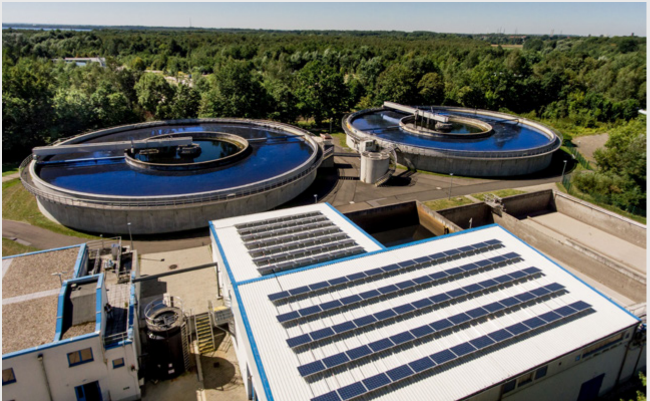
Bild 3: PV-Anlage auf dem Dach der KA Markkleeberg. Die Erhöhung des Anteils erneuerbarer Energien ist eines der Nachhaltigkeitsziele der Leipziger. Die Monats- und Jahresberichte Energiemanagement sind ebenfalls Teilberichte des Kennzahlensystems. sie stellen eine zentrale Grundlage für die externe Überprüfung und Zertifizierung des Energiemanagements nach ISO DIN 50001 dar
