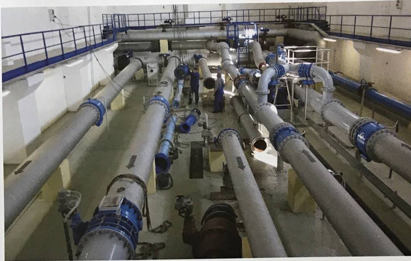
Einbau der Wasserkraftanlage an der Trinkwasserleitung am Hochbehälter 08 in Gotha (Kleiner Seeberg)
