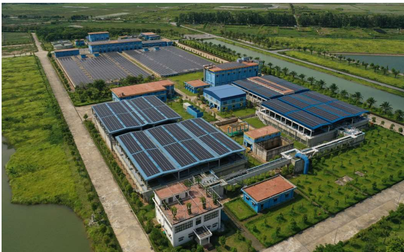
Bild 1: Das Wasserwerk in Vietnam wird nach deutschen Standards errichtet.
