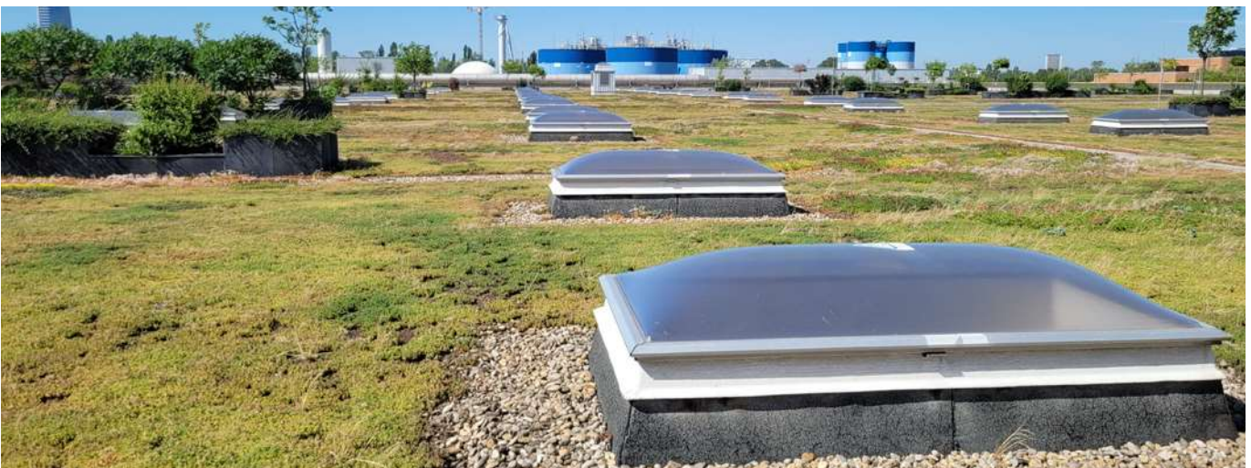
Bild 3: Ein Großteil der Becken ist eingehaust, die Dächer begrünt.
