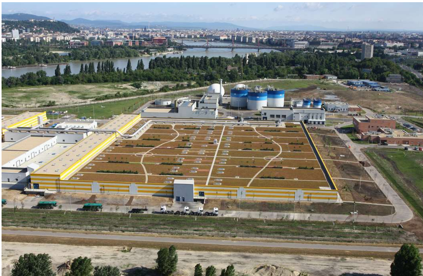
Bild 1: Die moderne Kläranlage liegt direkt vor den Toren der historischen Innenstadt von Budapest.
