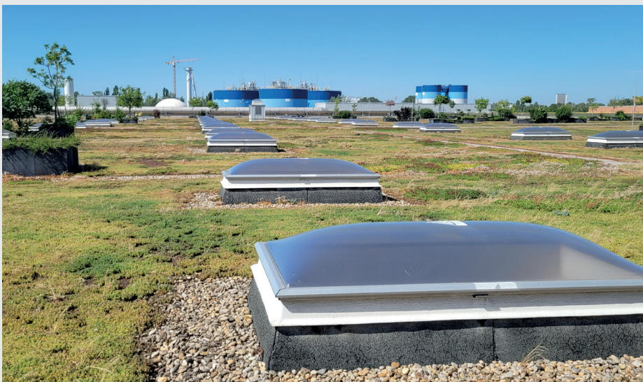
Bild 2 Ein Großteil der Becken ist eingehaust, die Dächer sind begrünt.
