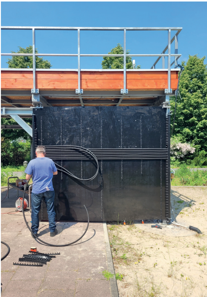
Bild 1 Solarabsorber an der Pilotanlage „Carport“ während der Montagearbeiten Quelle: UFZ Leipzig
