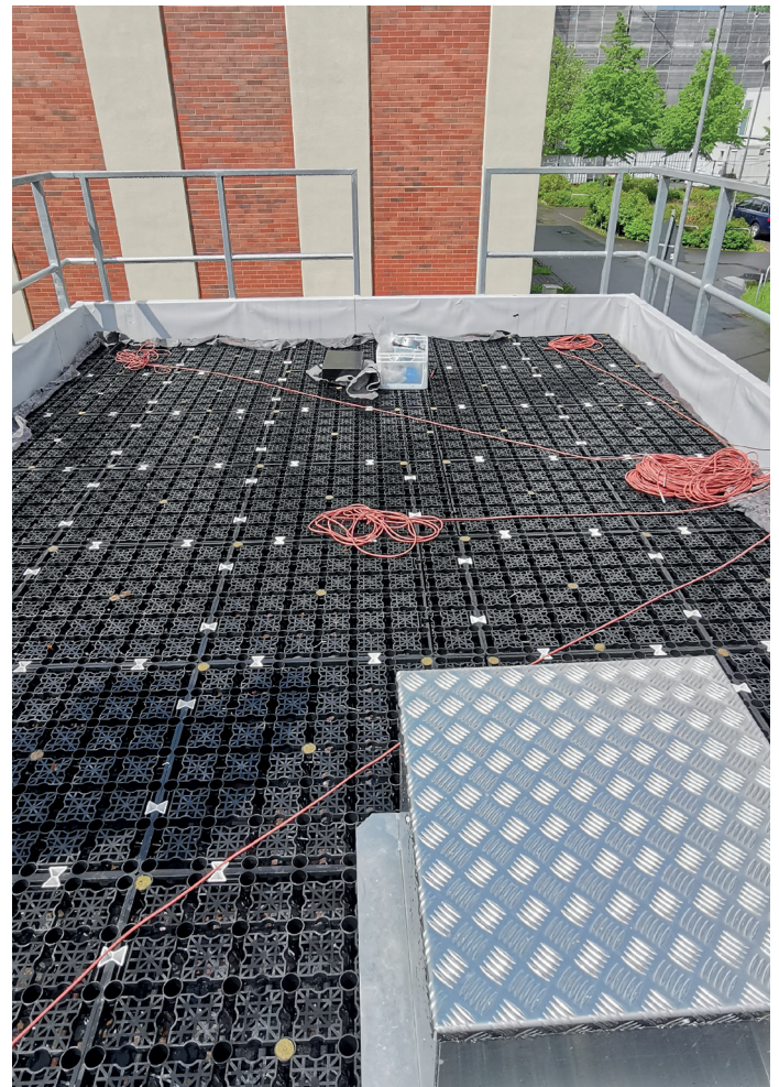
Bild 2 Oberbau des Gründachs mit den Retentionsboxen vor der Substratbefüllung Quelle: UFZ Leipzig
